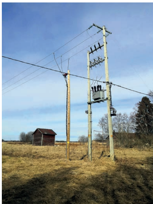
Kuva 2. Keskijännitelinjaa Limingan Alapäässä. Muuntajan tukemiseen tarvitaan kaksi johdinpylvästä. Silloin orsiakin on yleensä kaksi tai jopa kolme, kuten kuvassa. Muuntajaa tukeva teräspalkki ei välttämättä ole onnto, eikä sovellu siten pesimiseen. © TEPPO MUTANEN
