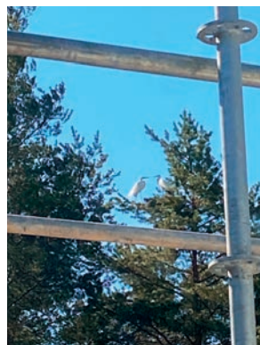
Haikaroiden pesää ja remontissa olevan kerrostalon rakennustelineitä erotti Lämsänjärvellä vain katu ja pyörätie. © SASU KÄRKKÄINEN
